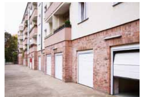
Garagen in der Burchardstraße
